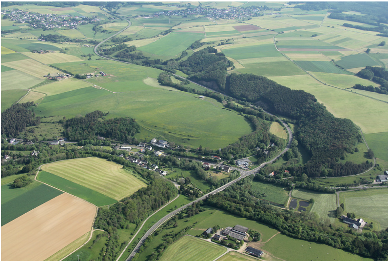
Ahrhütte von Südwesten (2012) Fotograf/Urheber: Andreas Schmickler
