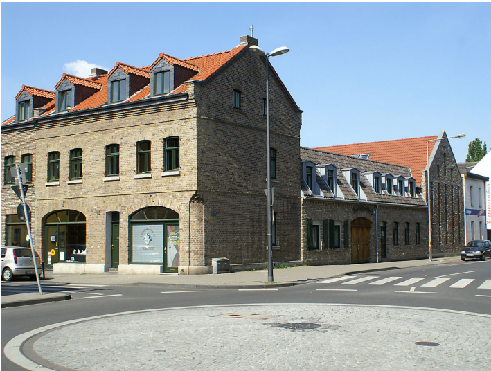
Restauriertes Hofgebäude an der Ecke Subbelrather Straße / Rochusstraße in Köln-Bickendorf (2010) Fotograf/Urheber: Rolf Heinrich
