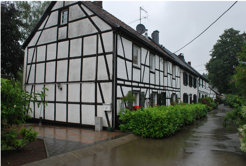
Arbeiterhäuser in der Siedlung "Am Kunstfeld" (2014) Fotograf/Urheber: Gelhar, Martina
