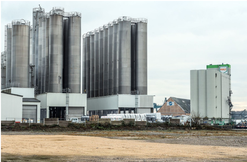
Silos am Niehler Hafen (2018) Fotograf/Urheber: Jürgen Gregori
