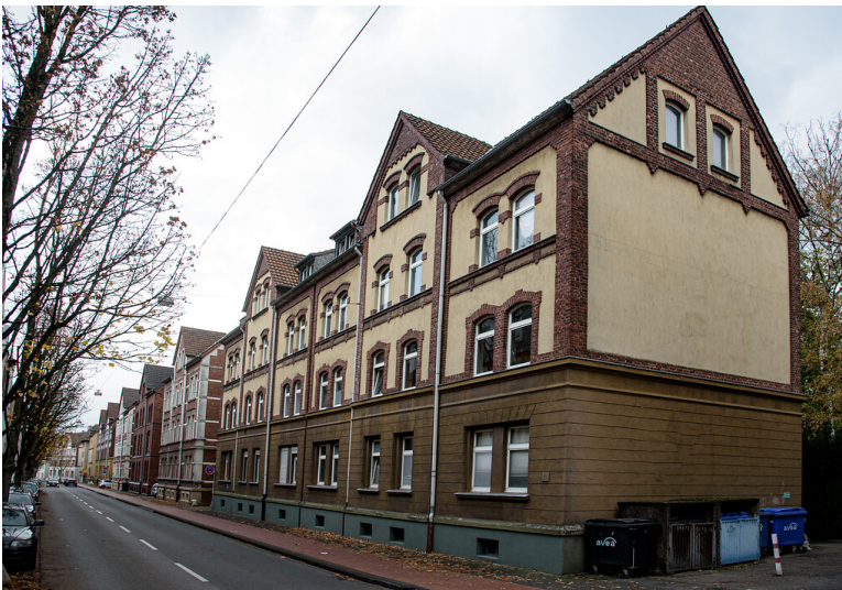
Reihenhäuser der Eisenbahnersiedlung in Opladen (2021) Fotograf/Urheber: Kurt Kailß
