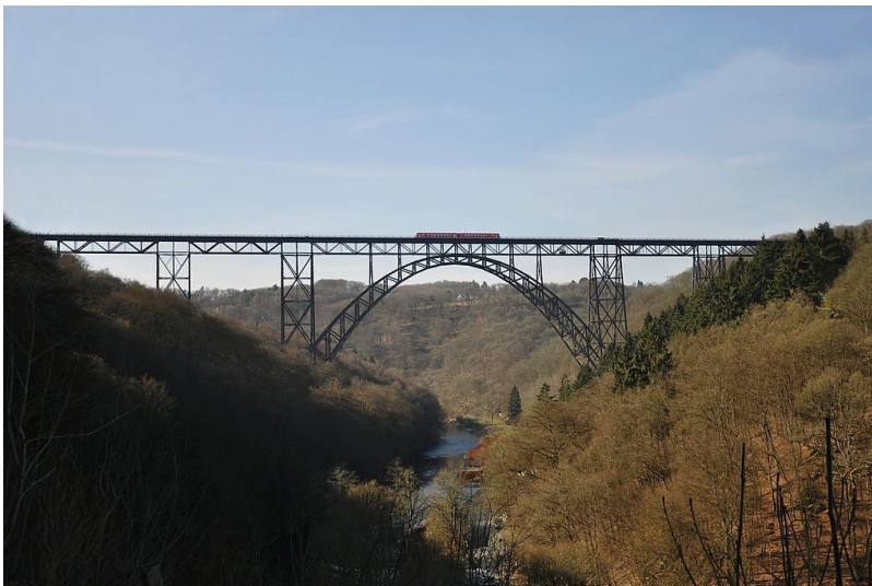
Die Müngstener Brücke zwischen den Städten Remscheid und Solingen (2013) Fotograf/Urheber: InterCityImpress
