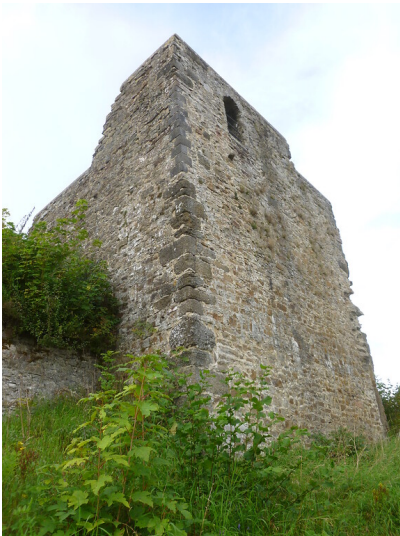
Turm der Burgruine Kronenburg, Südwestseite (2014) Fotograf/Urheber: Annette Schwabe
