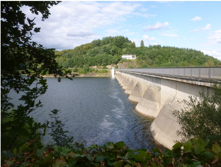
In Pfeilerzellenbauweise aus Beton erbaute Staumauer der Oleftalsperre (2014) Fotograf/Urheber: Annette Schwabe
