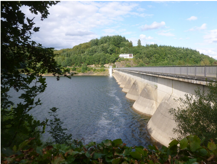
In Pfeilerzellenbauweise aus Beton erbaute Staumauer der Olefalsperre (2014) Fotograf/Urheber: Annette Schwabe
