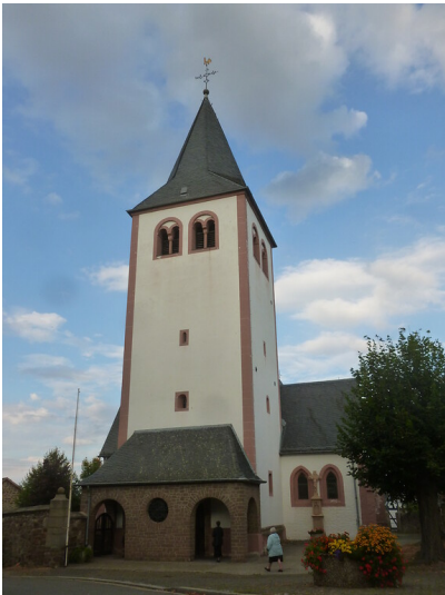
Pfarrkirche St. Andreas in Glehn mit spätromanischem Turm (2014) Fotograf/Urheber: Annette Schwabe
