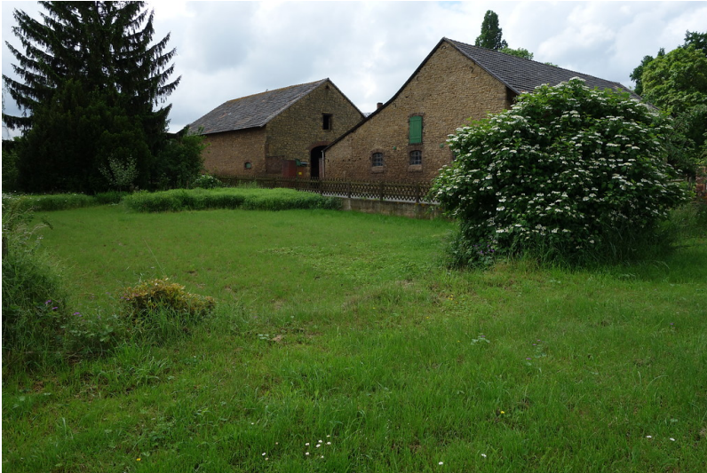
Gebäude der Achmer Mühle bei Floisdorf (2016) Fotograf/Urheber: Martina Gelhar
