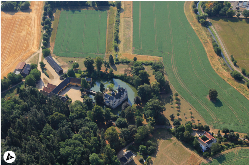
Luftbild über die Burg Kriegshoven mit Nordpfeil (2018) Fotograf/Urheber: Andreas Schmickler
