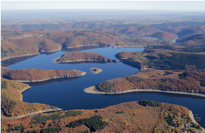
Rurtalsperre (2016) Fotograf/Urheber: Andreas Schmickler
