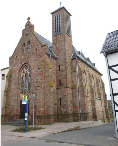
Pfarrkirche St. Gereon in Boich, erbaut aus Bruchsteinen im neogotischen Stil (2015) Fotograf/Urheber: Annette Schwabe
