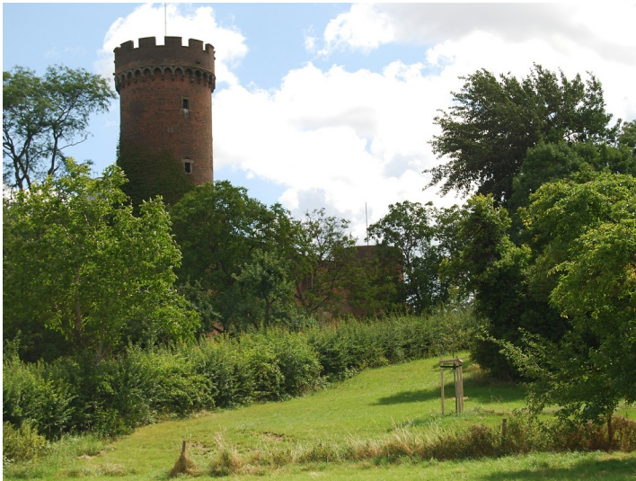
Landesburg Zülpich Fotograf/Urheber: LVR-Amt für Bodendenkmalpflege
