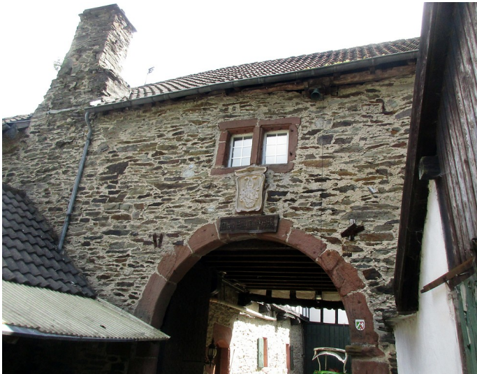
Der Eingang zum auch "Burg" genannten Kremerhof von 1643 im heutigen Hürtgenwalder Ortsteil Simonskall (2017).
