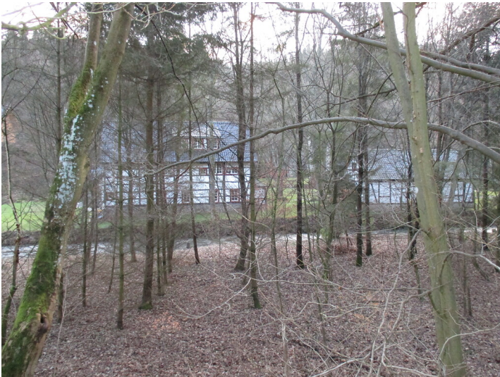
Gebäude auf dem Areal des ehemaligen Hüttenwerks Zweifallshammer (2015) Fotograf/Urheber: Annette Schwabe
