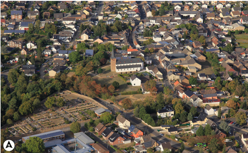
Luftbildaufnahme der Pfarrkirche St. Pankratius mit Nordpfeil (2018) Fotograf/Urheber: Andreas Schmickler
