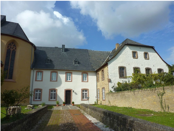
Klostergebäude der 1802 aufgehobenen Zisterzienserrinnenabtei "St. Stephani Auffindung" in Zülpich-Bürvenich (2015), links davon die heutige Pfarrkirche St. Stephanus. Fotograf/Urheber: Chris06
