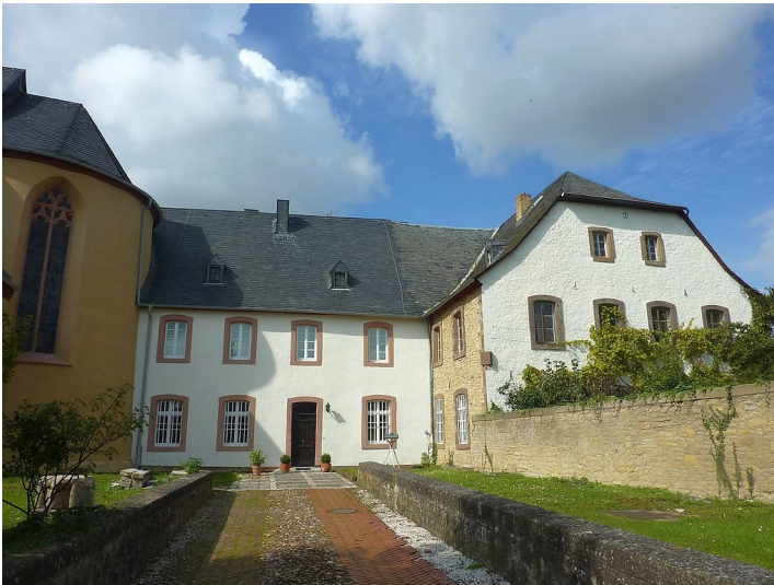
Klostergebäude der 1802 aufgehobenen Zisterzienserinnenabtei "St. Stephani Auffindung" in Zülpich-Bürvenich (2015), links davon die heutige Pfarrkirche St. Stephanus. Fotograf/Urheber: Chris06
