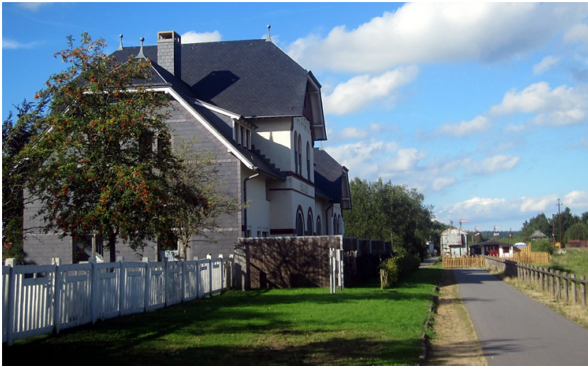
Das Empfangsgebäude des einst bedeutenden Bahnhofs in Sourbrodt (Belgien), einer ehemaligen Station der Vennbahn (2015). Fotograf/Urheber: Knöchel; Franz-Josef
