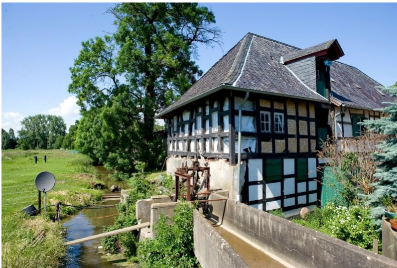
Das Fachwerkgebäude der Bliesheimer Mühle mit Mühlgraben und Zulauf Fotograf/Urheber: Pientka, Nicole
