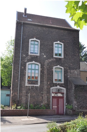
Pumpenhaus an der Ecke Luisenstraße/Stolbergerstraße in Eschweiler-Pumpe (2014) Fotograf/Urheber: Tonhauser, Fine
