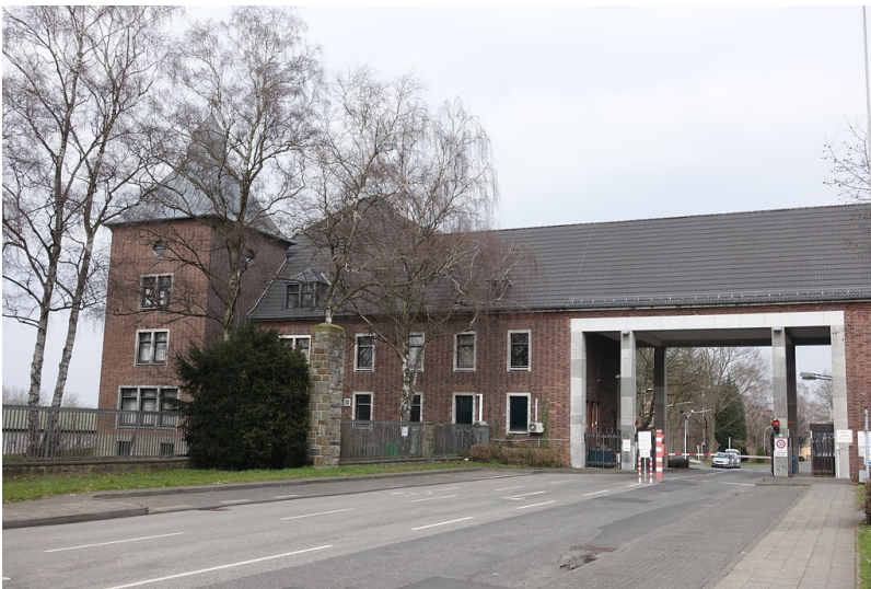
Eingangsgebäude der Lützow-Kaserne (2015) Fotograf/Urheber: Fine Tonhauser
