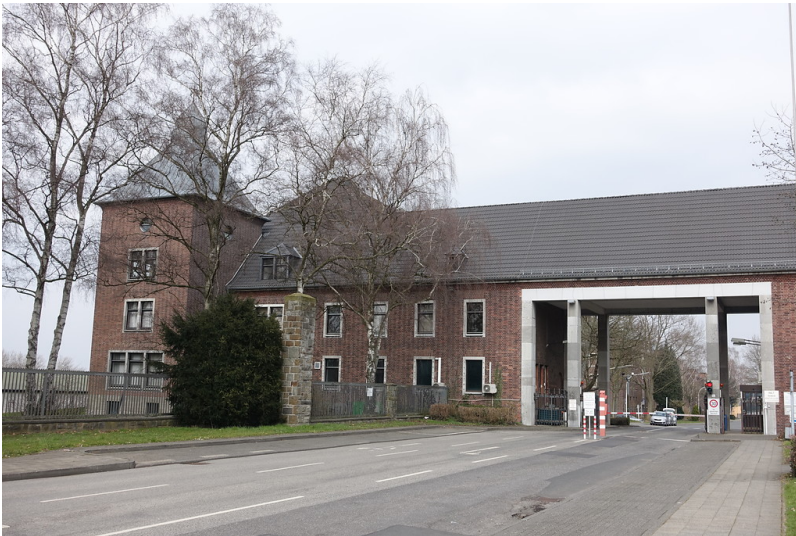
Eingangsgebäude der Lützow-Kaserne (2015) Fotograf/Urheber: Fine Tonhauser
