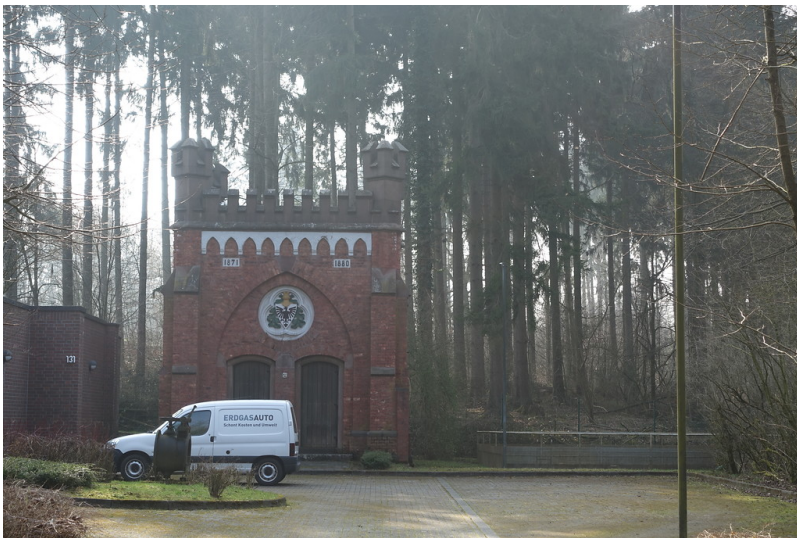
Eingangsgebäude Eicher Stollen (2015) Fotograf/Urheber: Fine Tonhäuser
