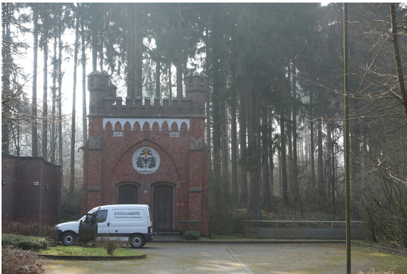
Eingangsgebäude Eicher Stollen (2015) Fotograf/Urheber: Fine Tonhäuser
