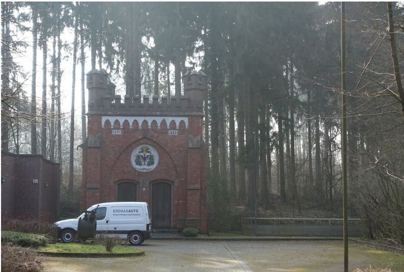
Eingangsgebäude Eicher Stollen (2015) Fotograf/Urheber: Fine Tonhäuser
