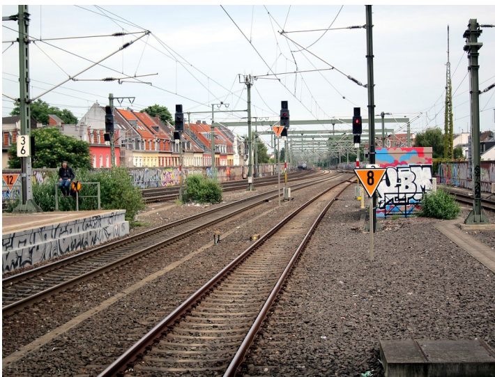
Gleisanlagen der Bahnstrecke Köln-Aachen im Bereich des Bahnhofs Köln-Ehrenfeld in Blickrichtung Osten (2015) Fotograf/Urheber: Knieps, Elmar
