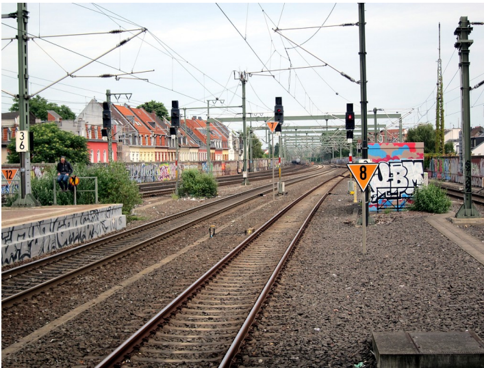
Gleisanlagen der Bahnstrecke Köln-Aachen im Bereich des Bahnhofs Köln-Ehrenfeld in Blickrichtung Osten (2015) Fotograf/Urheber: Knieps, Elmar
