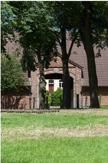
Gut Gommershoven, Außenansicht des Eingangstors (2014). Fotograf/Urheber: Silvia Margrit Wolf
