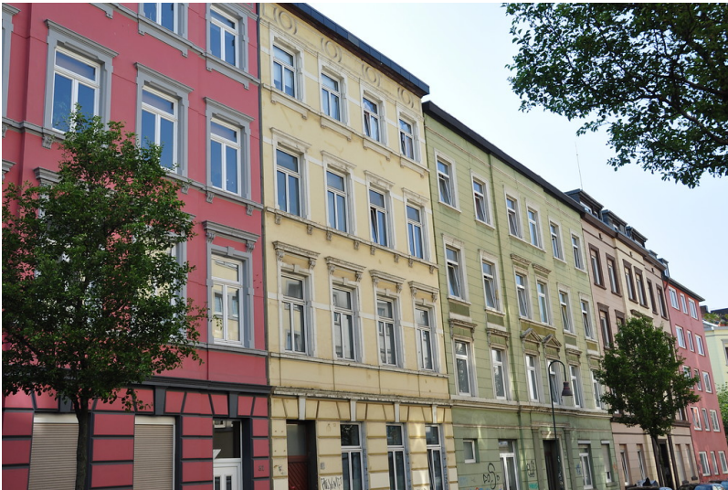
Aachen Ostviertel (2014) Fotograf/Urheber: Fine Tonhauser
