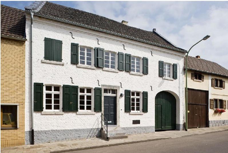
Die ehemalige Synagoge Titz-Rödingen, heutiges LVR-Kulturhaus, nach der Sanierung (2010).
