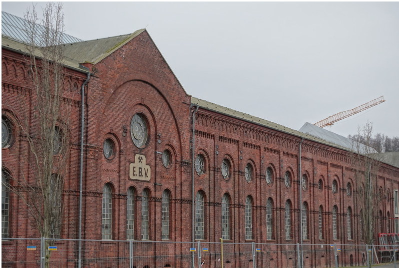
Elektrohauptwerkstatt der Grube Anna (2015) Fotograf/Urheber: Fine Tonhauser
