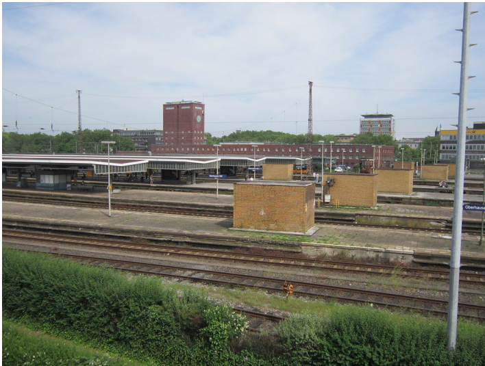
Oberhausen Hauptbahnhof, Blick über das südliche Gleisfeld mit den ehemaligen Gepäckaufzügen (2016) Fotograf/Urheber: Claus Weber
