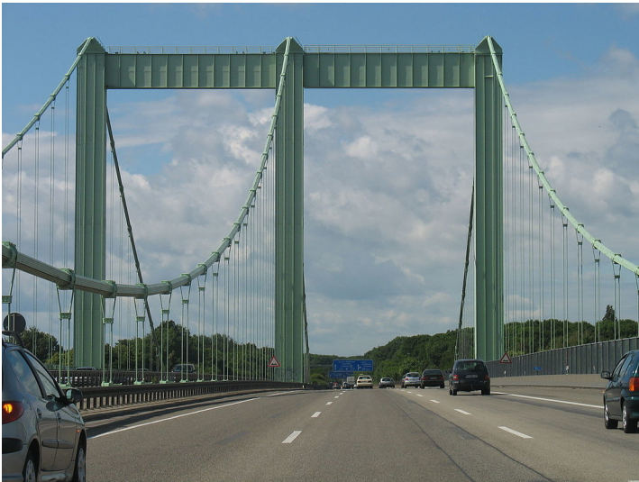
Die Rodenkirchener Autobahnbrücke über den Rhein, Aufnahme von der Autobahn A 4 aus in Fahrtrichtung Westen (2009) Fotograf/Urheber: Klaus Foehl
