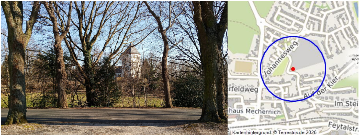
Katholische Pfarrkirche St. Johannes Baptist in Mechernich (2022) Fotograf/Urheber: Annette Schwabe
