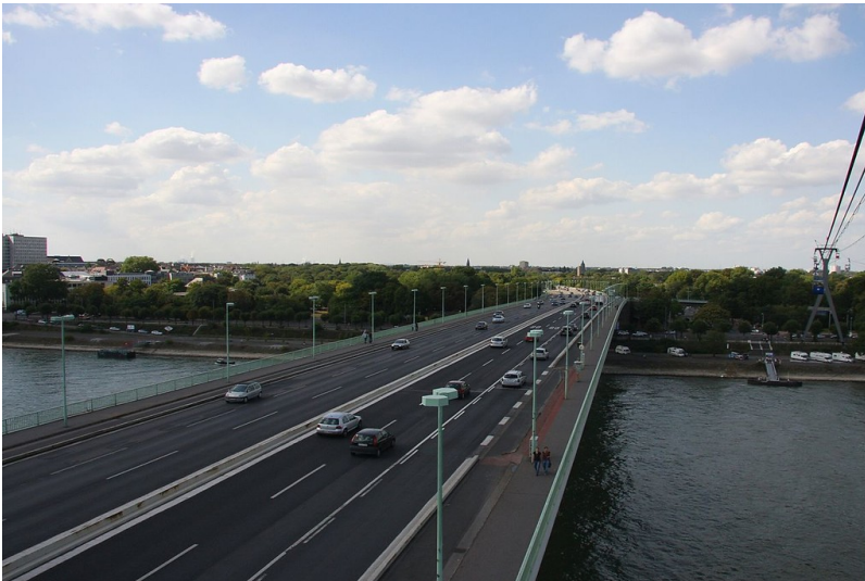
Die Kölner ZooBrücke über den Rhein, Aufnahme aus der Rheinseilbahn heraus in Richtung Westen (2009) Fotograf/Urheber: D-Kuru
