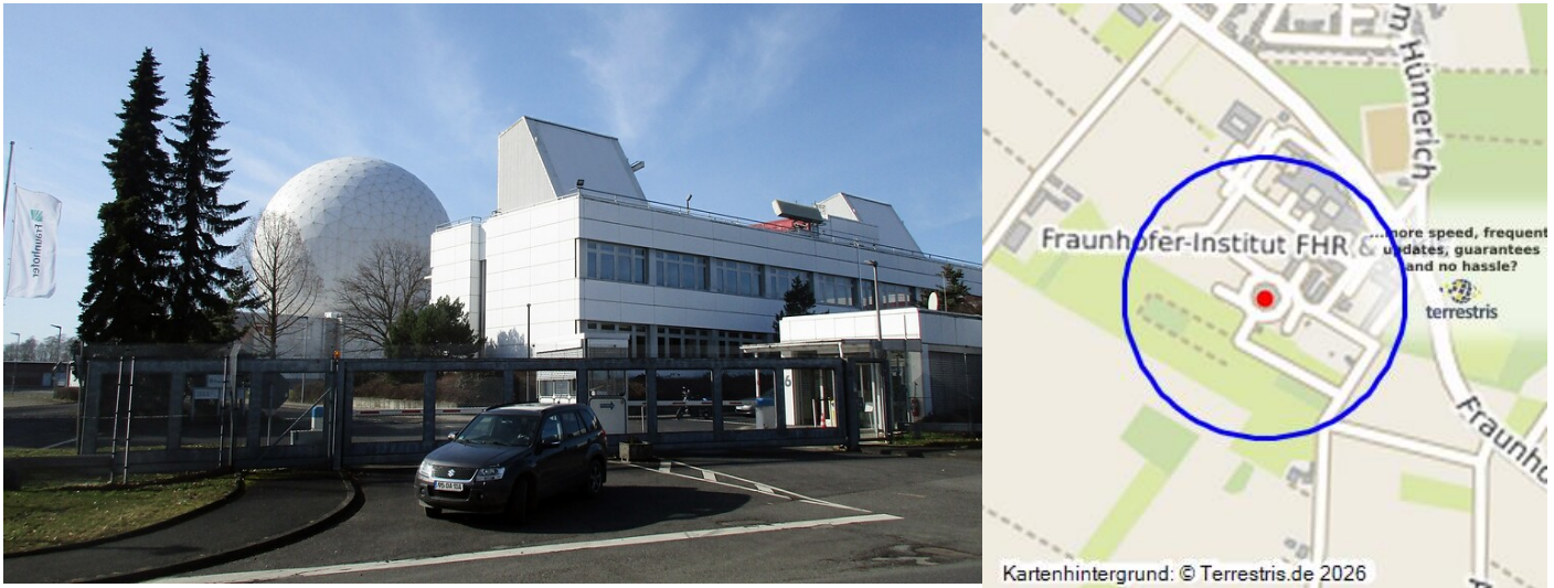
Blick von Norden auf die Radarkuppel des "Radar dome" (Radom) auf dem Gelände des Fraunhofer-Instituts bei Wachtberg-Berkum (2021). Fotograf/Urheber: Franz-Josef Knöchel
