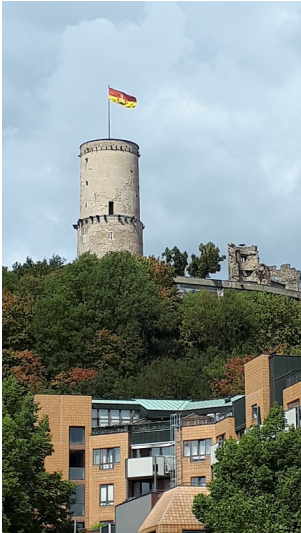
Ansicht der Godesburg von Bad Godesberg aus (2018). Fotograf/Urheber: Florian Weber
