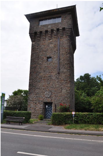
Hindenburgturm in Ketzbergerhöhe in Wermelskirchen (2015) Fotograf/Urheber: Karl-Heinz Buchholz
