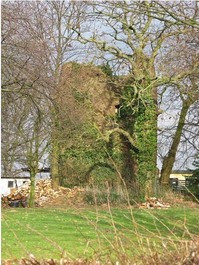
Blick auf den Mühlenstumpf der Settericher Windmühle von Westen (2011). Fotograf/Urheber: LoKiLeCh
