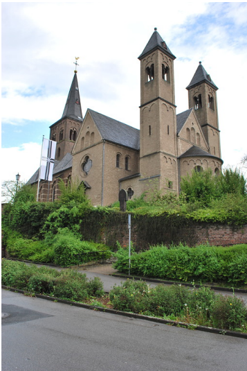
katholische Pfarrkirche St. Remigius, Bergheim (2015) Fotograf/Urheber: Martina Gelhar
