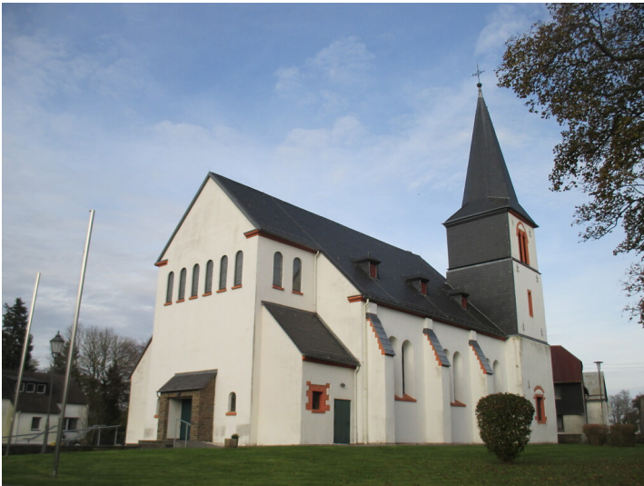
Die Pfarrkirche St. Barbara ist eine dreischiffige verputzte, weiß gestrichene Saalkirche mit im Süden angebautem Glockenturm. (2014) Fotograf/Urheber: Annette Schwabe
