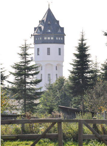
Wasserturm in Rösberg (2014) Fotograf/Urheber: Nicole Schmitz
