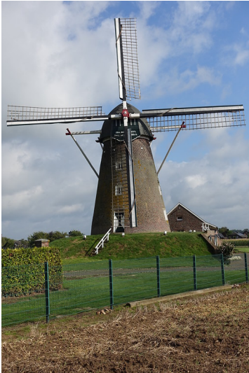
Haarener Windmühle (2017) Fotograf/Urheber: Axel Welp
