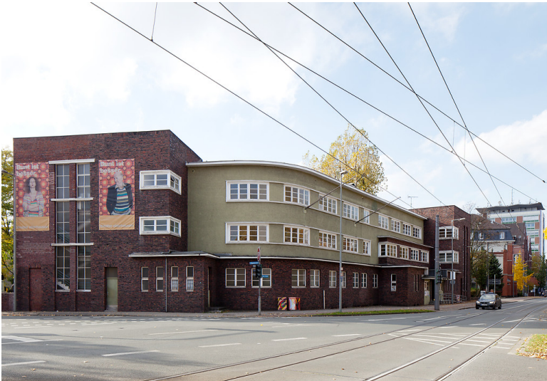
Oberhausen-Altstadt-Mitte, Danziger Str. 11 - 13, ehem. Arbeitsamt Fotograf/Urheber: Silvia Margrit Wolf
