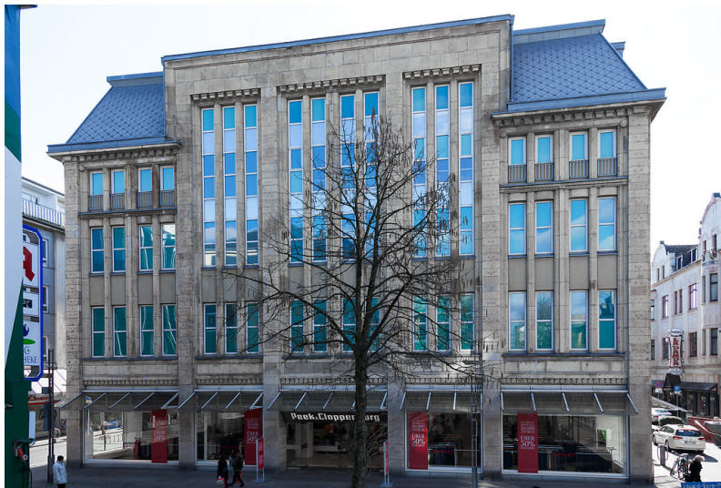
Oberhausen-Altstadt-Süd, Marktstr. 43, ehemaliges Kaufhaus Magis, Peek & Cloppenburg Fotograf/Urheber: Silvia Margrit Wolf
