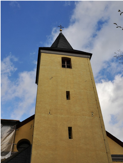
Kirchturm der Versöhnungskirche in Buschhoven (2016) Fotograf/Urheber: Felicitas Gildenhard
