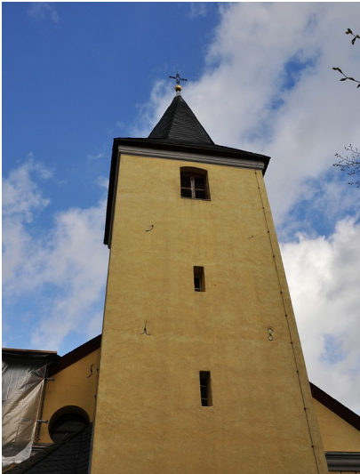
Kirchturm der Versöhnungskirche in Buschhoven (2016) Fotograf/Urheber: Felicitas Gildenhard
