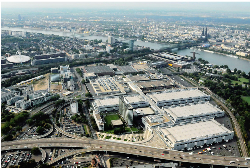
Luftaufnahme des modernen Teils der Kölner Messe mit Köln-Deutz und der Kölner Innenstadt mit Dom im Hintergrund (2009). Vorne im Bild die zur Zoobrücke führende Bundesstraße B 55a und links die Lanxess-Arena, das so genannte "Henkelmännchen". Fotograf/Urheber: unbekannt
