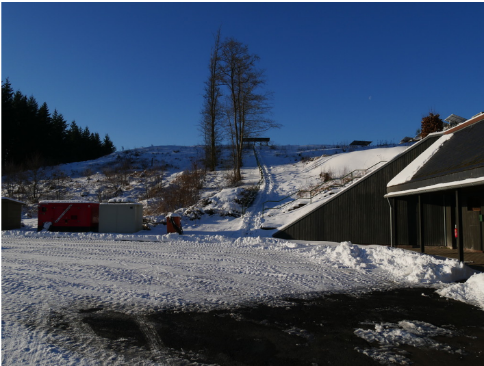
Eingang zum Bunker Erwin bei Börfink (2017) Fotograf/Urheber: Jörn Schultheiß
