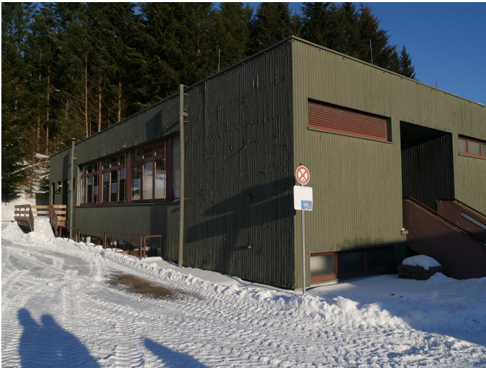
Ehemalige Mensa des Bunkers Erwin bei Börfink (2017) Fotograf/Urheber: Jörn Schultheiß
