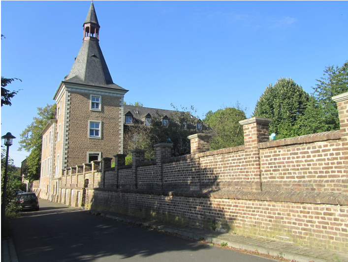
Herrenhaus des Wirtschaftshofes und Klostermauer des ehemaligen Klosters Benden (2014) Fotograf/Urheber: Nicole Schmitz
